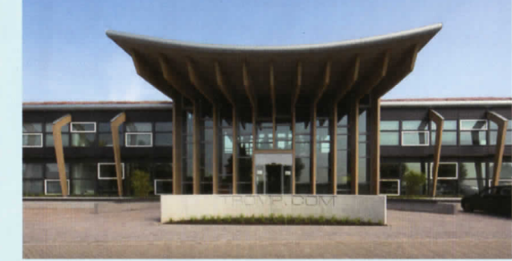
Monumentale entreepartij buigt richting de natuur er tegenover. Opbouw met houten spanten maakte complexe halle-bolle dakvorm eenvoudig realiseerbaar
