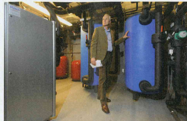
Energiespecialist Paul Heistein inspecteert het ketelhuis. Het ziet eruit alsof je er van de grond kunt eten. Wim Tromp: “Bij Philips, waar ik ben opgeleid, zeiden ze: ‘op een mesthoop maak je geen kwaliteit!’”
